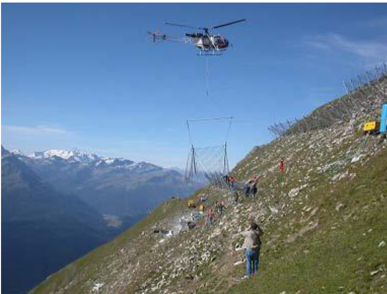
Installazione della struttura paravalanghe con l'ausilio dell'elicottero
