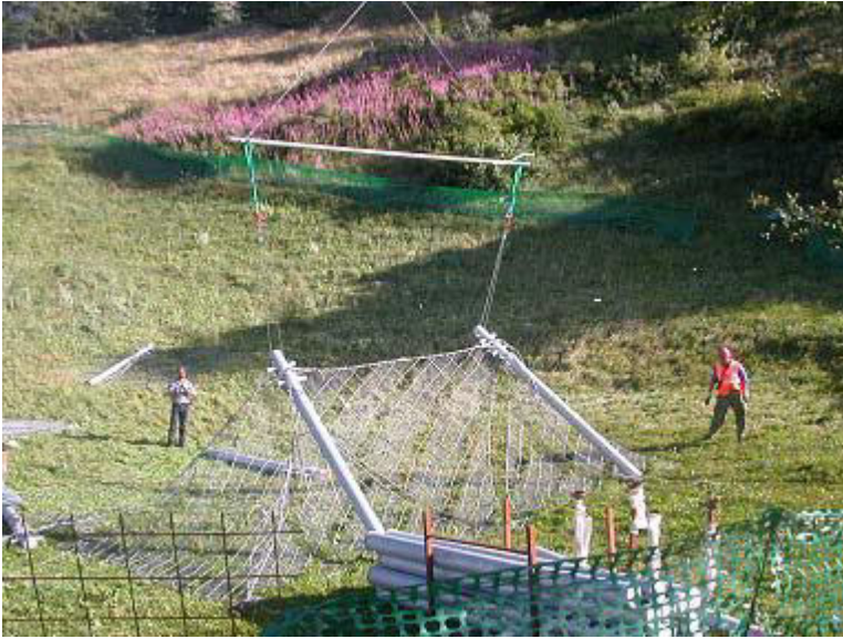
Preparazione di una struttura paravalanghe
